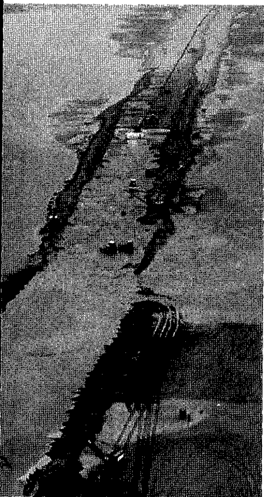
De sluiting met zand van het Brielse Gat in zijn laatste fase; bulldozers en draglines werken het profiel bij
